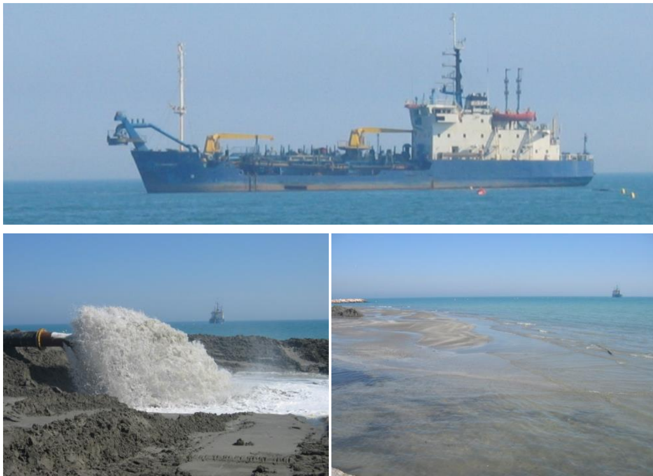
Foto 5.1: Nave con draga aspirante nell'Area JC ed azione di pompaggio della sabbia ad Eraclea (2004).
